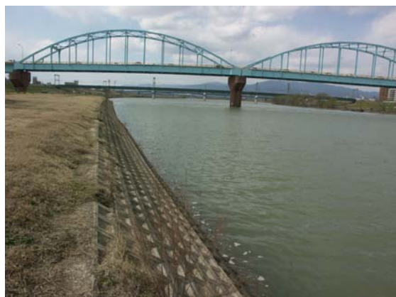
写真4-2-9 宮ノ陣橋上流付近の河岸 (久留米市)
