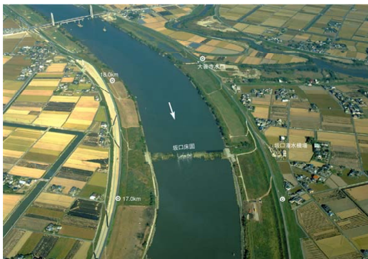
写真4-2-4 坂口床固付近(みやき町)
