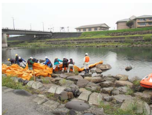
写真4-3-20 水質事故発生時の対応 水質事故発生時には、適切な箇所でオイルフェンスや吸着マットなどを設置し、下流への被害の拡大を防止します。
