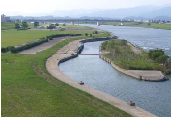
写真4-3-15 小森野床固の閘門 (久留米市)
