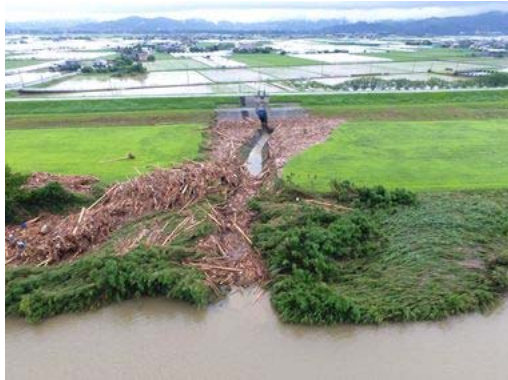
写真4-3-9 猿丸樋管の川表開水路に堆積した流木 (H29.7 出水)
