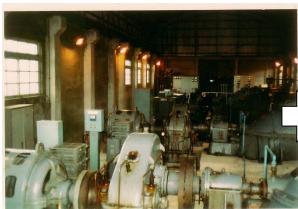
更新前(排水機場)
