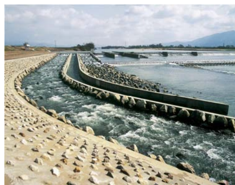
写真4-2-6 魚道のある堰(恵利堰:筑後川)
