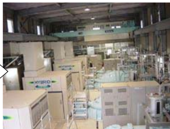
更新後(排水機場)
