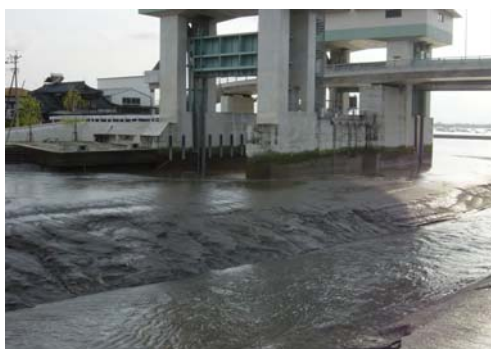
写真 4-3-7 ガタ土の堆積状況 (花宗水門)
