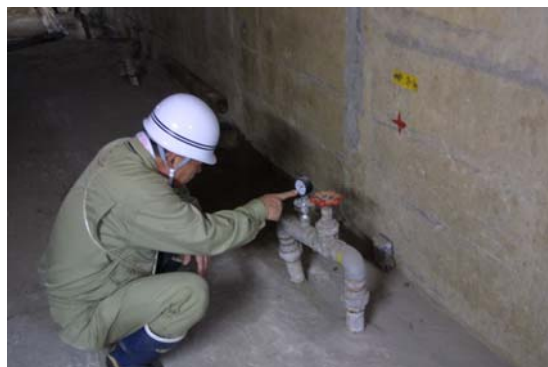
写真4-3-2 ダム等施設の点検
