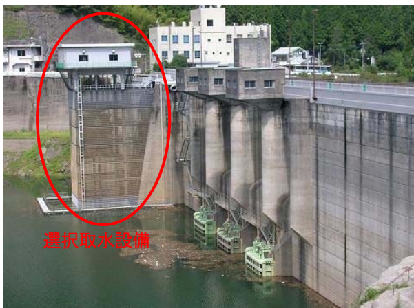
写真 4-2-8 松原ダムの選択取水設備
