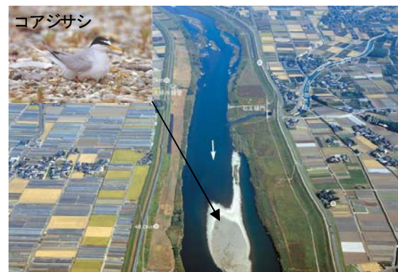
写真4-2-3 両筑橋上流付近(久留米市、朝倉市)
