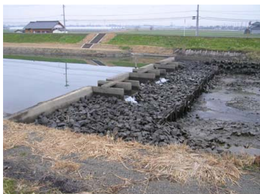
写真4-2-5 魚道のない堰(お茶屋堰:城原川)
