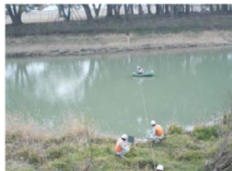
写真 5.2.1 河道の横断測量
