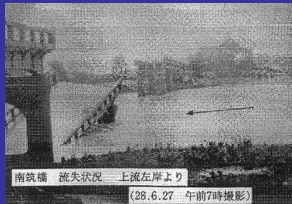
南筑橋流失状況 上流左岸より
