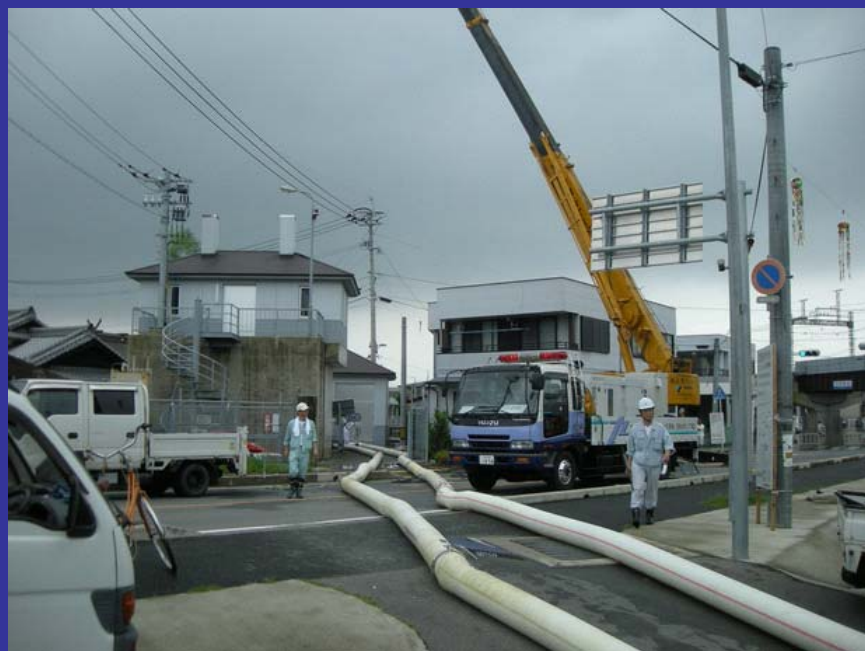
排水ポンプ車による排水作業(柳川市 平成21年)
