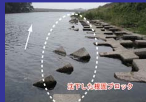
根固めが沈下し、釣り等安全に河川利用できない状況
