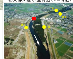
⑨矢部川船小屋付近(15k付近)
