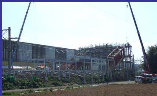
整備中の筑後船小屋駅
