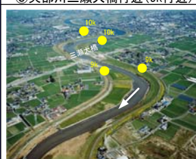
⑤矢部川三瀬大橋付近(9k付近)
