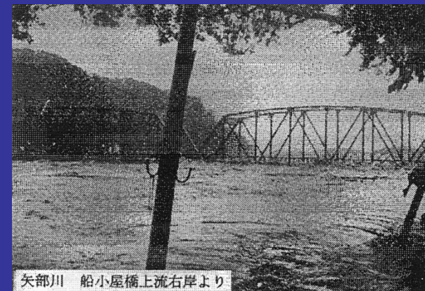
船小屋橋上流右岸より
