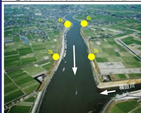
③飯江川合流点付近(5k付近)
