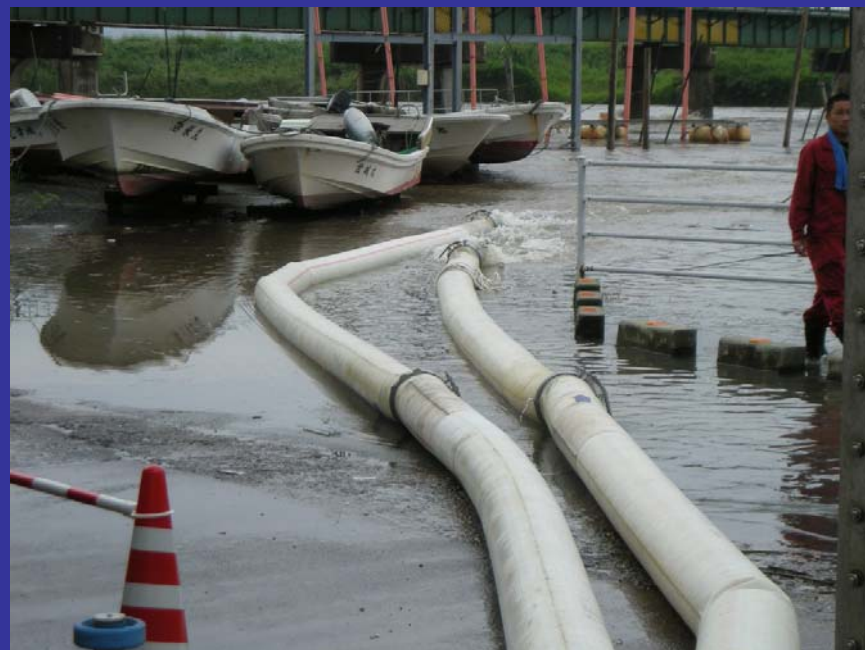
排水ポンプ車による排水作業(柳川市 平成21年)
