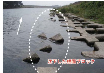
⑩根固めが沈降している (右岸上流側)
