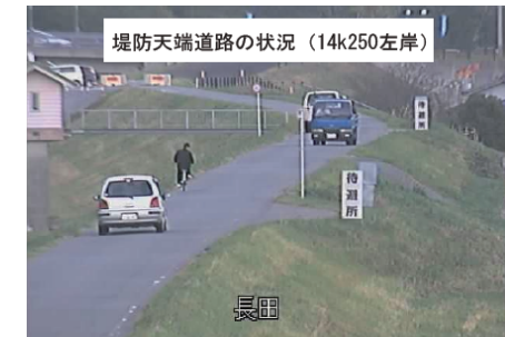
⑧左岸側堤防天端状況 (幅が狭く交通量が多い)
