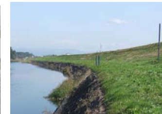
⑬護岸勾配が急で危険 (左岸側)
