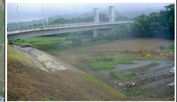
右岸17k000付近高水敷状況
