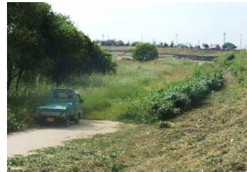
⑪散策路が途中で遮断 (右岸下流側)
