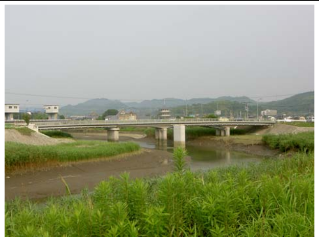
飯江川橋現況写真
