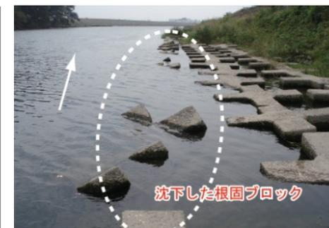
根固めブロックが沈下
