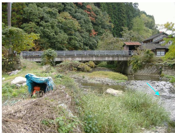
写真 1.18 田代川〔1/185、崩谷橋〕
