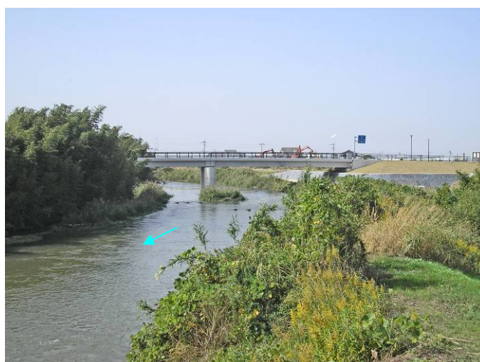
写真 1.6 沖端川〔13/600 付近、松原橋〕
