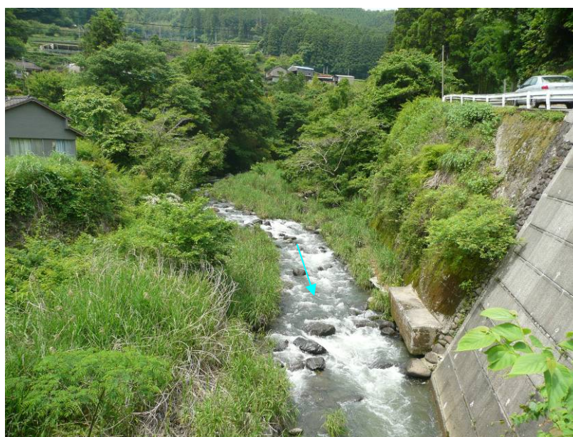
写真 1.16 広内川〔星野川合流点〕
