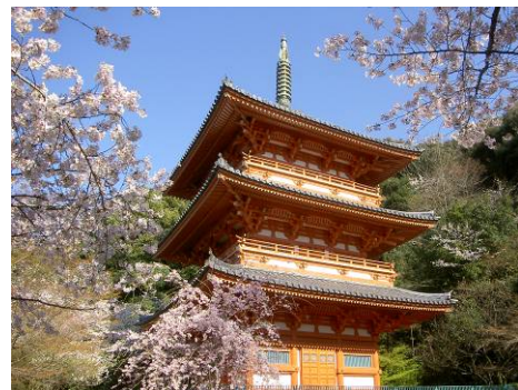
写真 1.29 県有形文化財 清水寺三重塔 (みやま市瀬高町)
