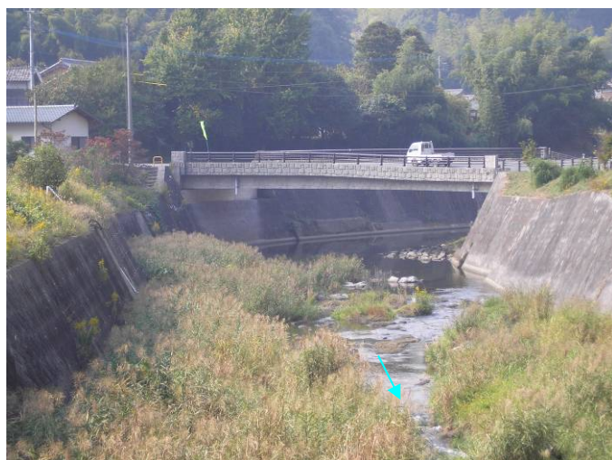
写真 1.10 白木川〔0/780、和田1号橋〕
