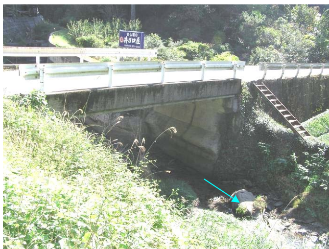
写真 1.14 下横山川〔二軒茶屋橋〕
