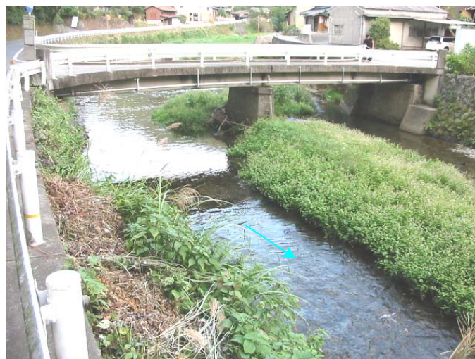
写真 1.15 横山川〔岩下橋〕
