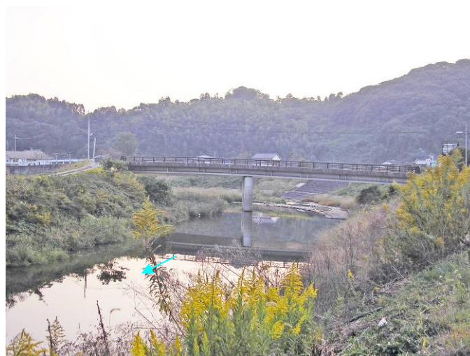
写真 1.11 辺春川 [1/300、中通り橋]
