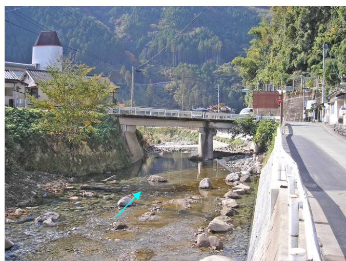
写真 1.22 御側川 [0/018、宮の尾橋]
