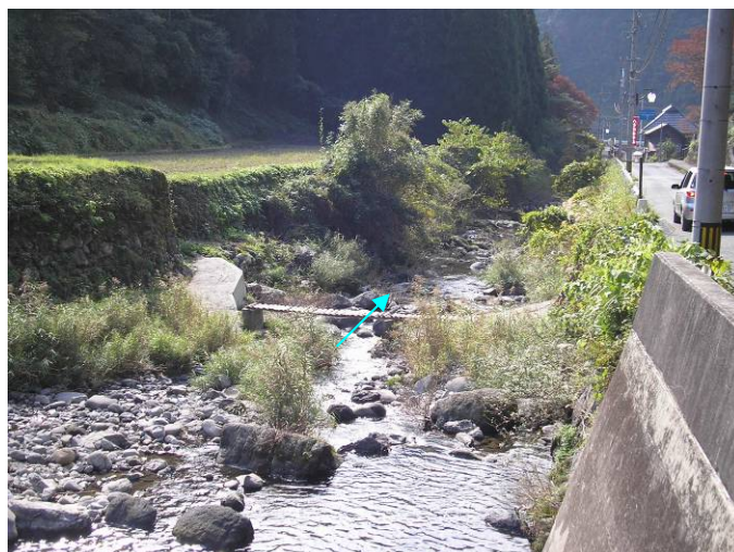
写真 1.21 縦鶴川 [0/250、無名橋]
