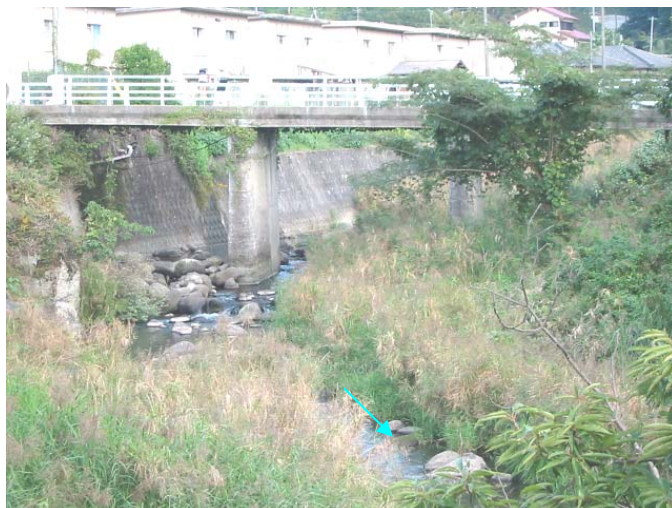
写真 1.17 龍川内川〔十龍橋〕
