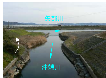
写真 2.9 沖端川分派状況
