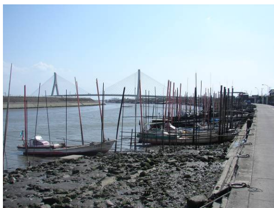
写真 1.34 浦島橋下流部右岸側
