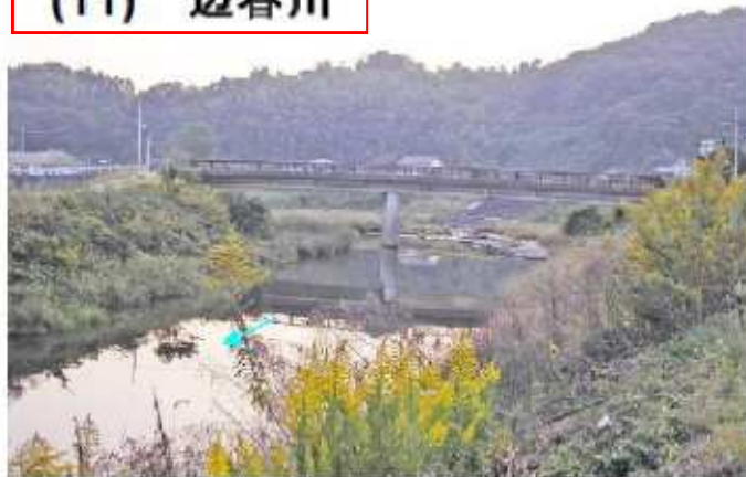
写真 1.11 辺春川 [1/300、中通り橋]
