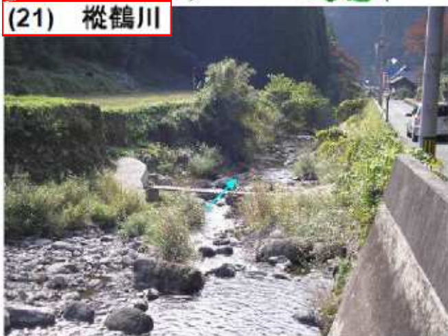
写真 1.21 縦鶴川 [0/250、無名橋]
