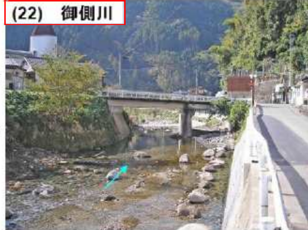
写真 1.22 御側川 [0/018、宮の尾橋]
