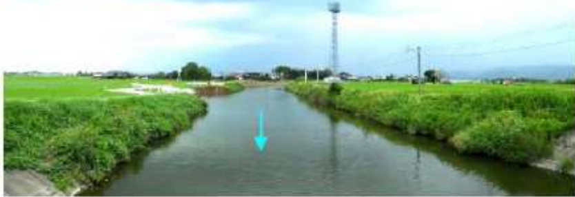
写真 1.4 大根川 [0/800、池の端橋より上流]
