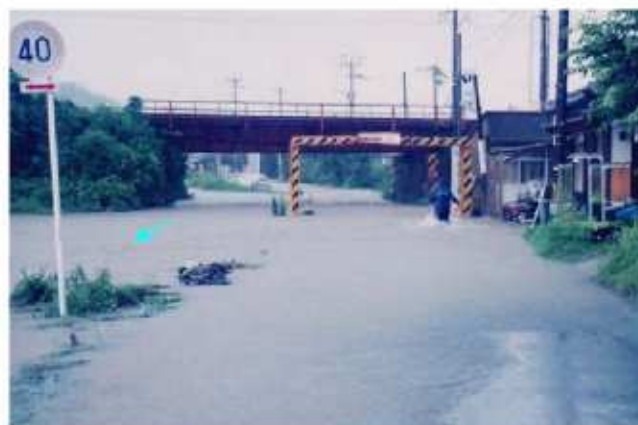
写真 2.1 平成2年7月洪水 楠田川 JR 付近の被災状況
