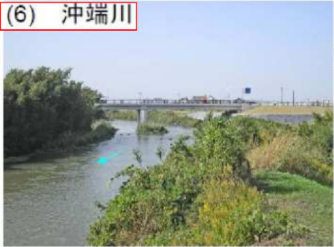
写真 1.6 沖端川 [13/600 付近、松原橋]
