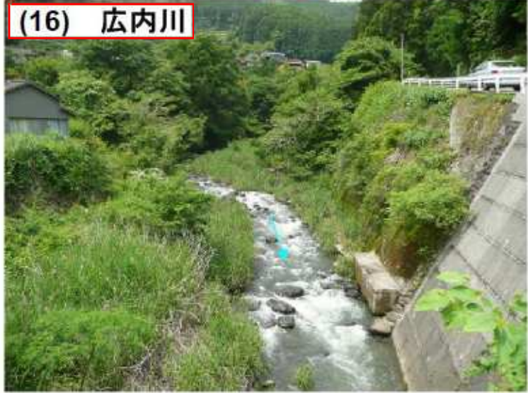
写真 1.16 広内川 [星野川合流点]
