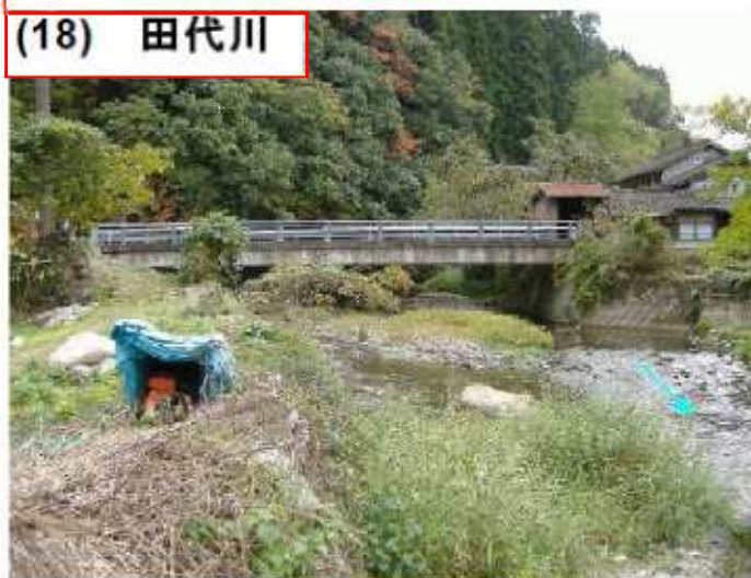
写真 1.18 田代川〔1/185、崩谷橋〕
