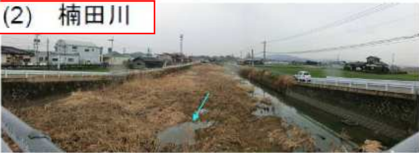
写真 1.2 楠田川 [3/200、濃施大橋より上流]
