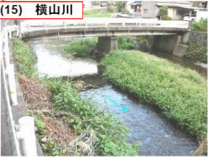
写真 1.15 横山川 [岩下橋]
