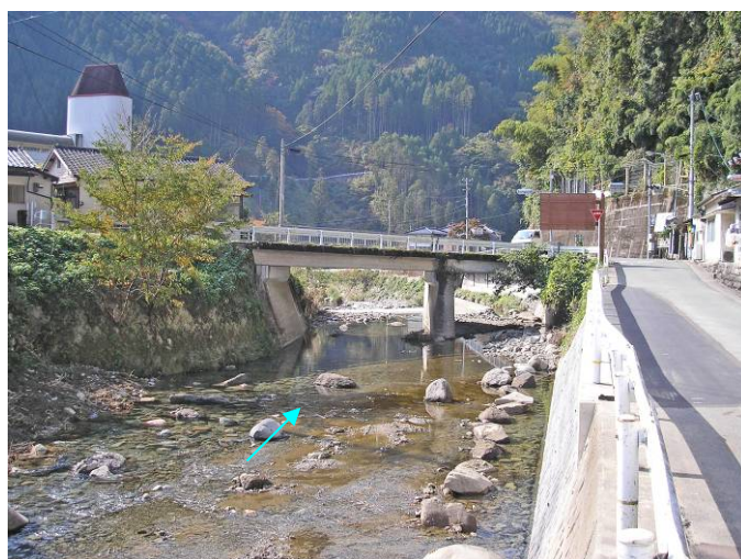
写真 1.22 御側川 [0/018、宮の尾橋]
