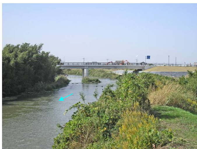
写真 1.6 沖端川〔13/600 付近、松原橋〕
