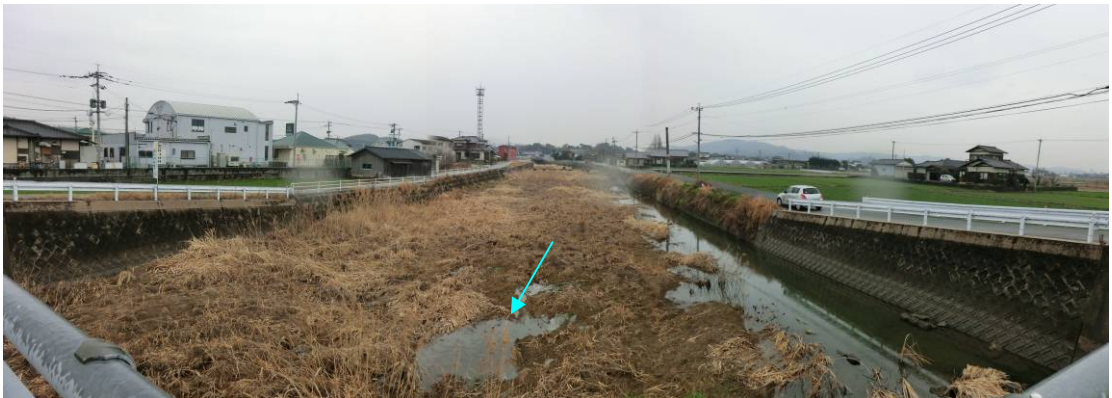
写真 1.2 楠田川 [3/200、濃施大橋より上流]
