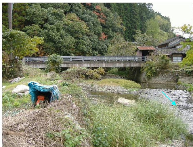
写真 1.18 田代川〔1/185、崩谷橋〕
