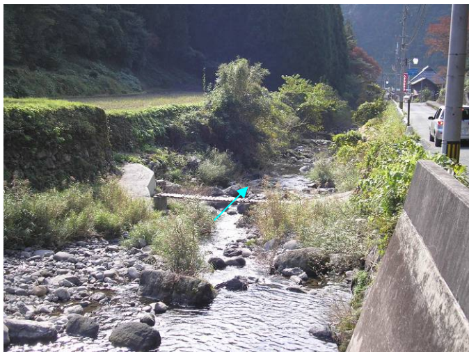
写真 1.21 縦鶴川 [0/250、無名橋]
