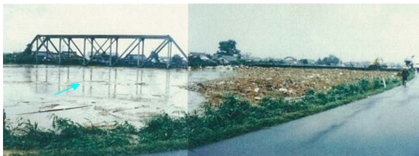
写真 2.2 平成2年7月洪水 沖端川橋付近の被災状況
