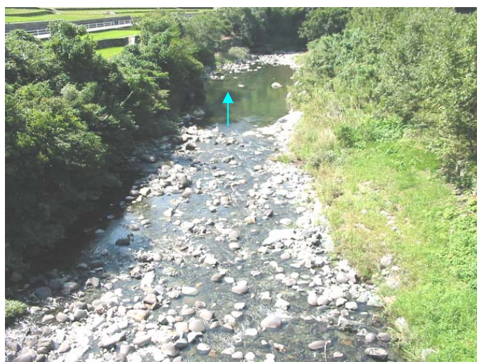
写真 1.13 星野川〔小淵橋より下流〕
