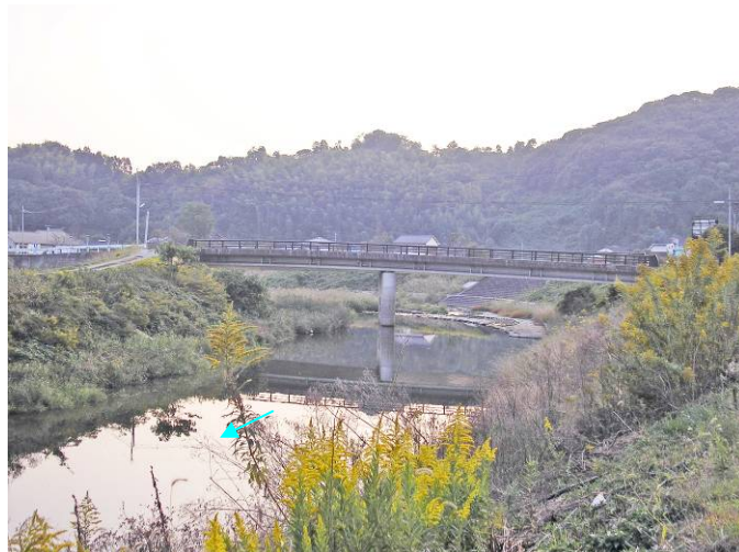
写真 1.11 辺春川 [1/300、中通り橋]
