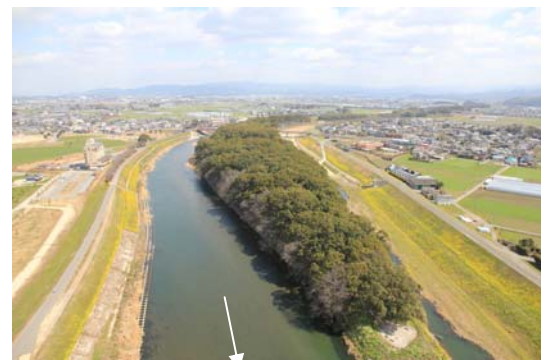
写真 1.25 矢部川中流部（船小屋温泉大橋付近）
