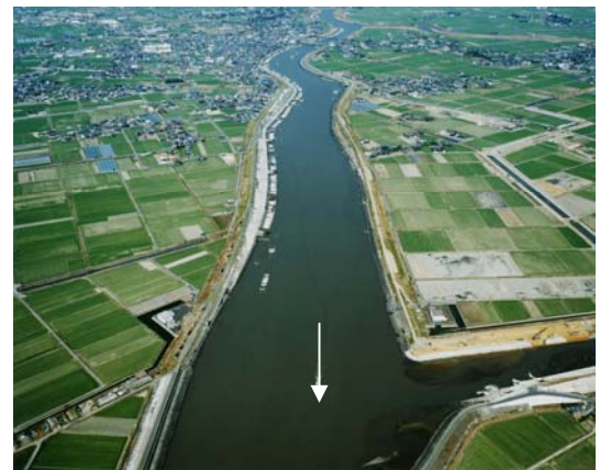
写真 1.27 矢部川下流部（飯江川合流点付近）
