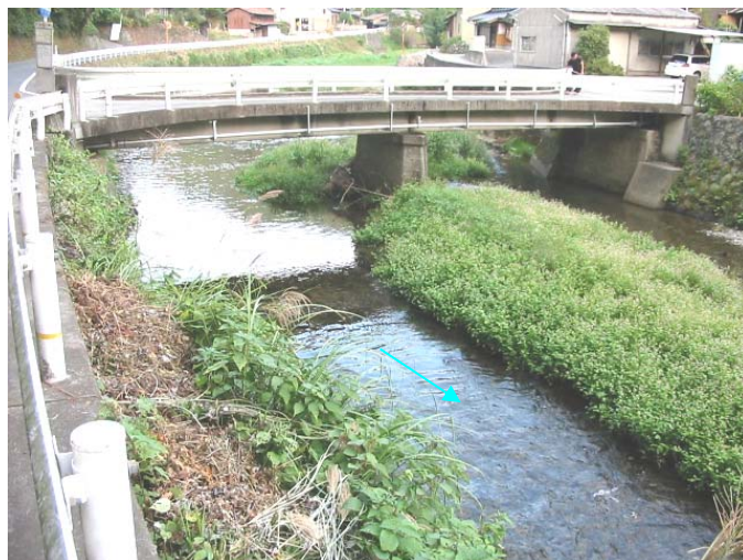
写真 1.15 横山川〔岩下橋〕
