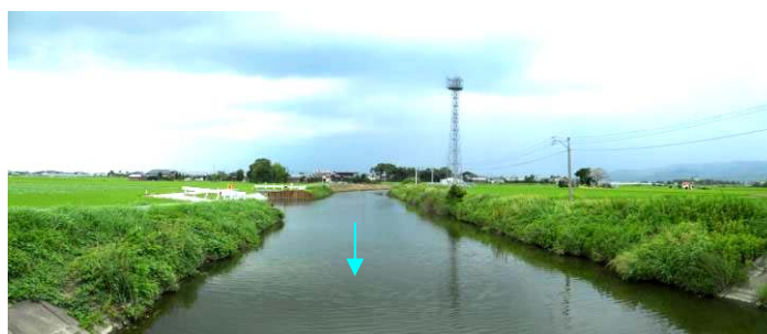
写真 1.4 大根川 [0/800、池の端橋より上流]
