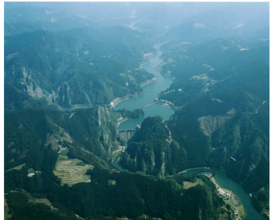
写真 1.26 矢部川上流部（日向神ダム付近）
