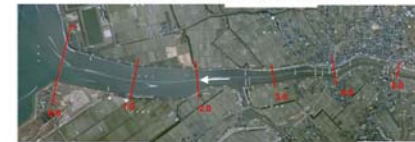
写真 3.1.18 河口部航空写真（平成 19 年）
