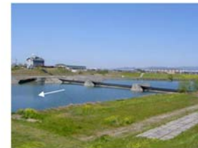
写真 2.2.20 松原堰 (みやま市)
