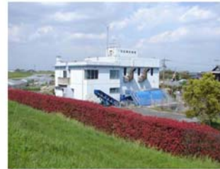
写真 3.1.14 文広排水機場（みやま市） 【矢部川左岸 11k000 付近】
