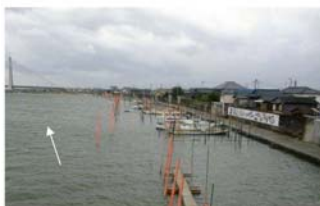
写真 3.1.1 浦島橋右岸側状況（柳川市）
