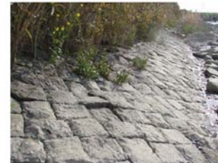
写真 3.1.9 老朽化した堤防護岸
