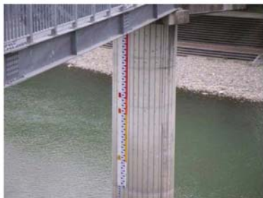
写真 5.3.6 川の水位情報（危険度レベル）を目印として現地に設置した例（矢部川船小屋水位観測所）
