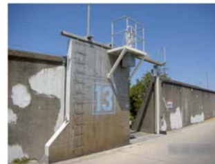
写真 3.1.16 陸開（柳川市） 【矢部川右岸 4k400 付近】
