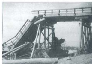
写真 2.2.7 洪水により壊れた幸作橋 （現：みやま市瀬高町）
