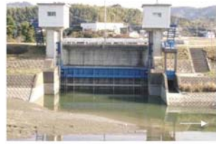
写真 3.1.12 古賀水門（みやま市） 【飯江川左岸 3k000 付近】
