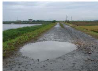
写真 3.1.10 堤防天端部の不陸の状況
