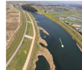
写真 3.3.8 船小屋地区のワンド
