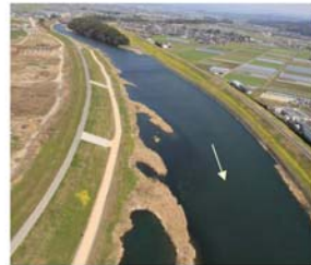
写真 3.3.8 船小屋地区のワンド
