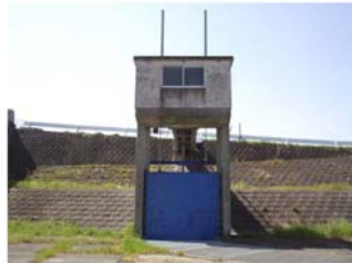
写真 3.1.11 日渡樋管（みやま市） 【矢部川左岸 10k200 付近】
