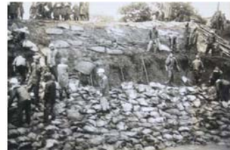
写真 2.2.11 矢部川はん蓋後の復旧状況 （現：みやま市瀬高町）
