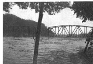
写真 2.2.6 矢部川のはん濫状況（船小屋） （現：筑後市船小屋）
