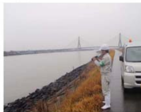
写真 5.3.1 河川巡視状況
