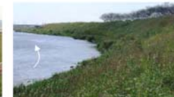
写真 3.3.20 船小屋地区の河川状況 (河川敷が狭く、河川敷及び水際へ安全にアクセスができない)
