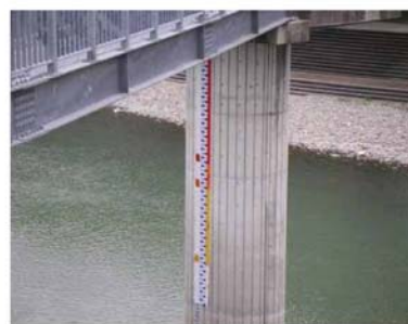
写真 5.3.6 川の水位情報（危険度レベル）を目印として現地に設置した例（矢部川船小屋水位観測所）
