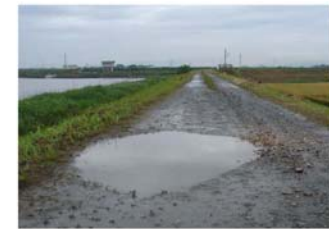
写真 3.1.10 堤防天端部の不陸の状況
