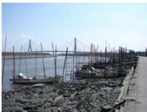
写真 2.1.11 浦島橋下流部右岸側
