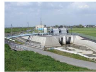
写真 3.1.13 川内排水機場（みやま市） 【矢部川左岸 5k400 付近】
