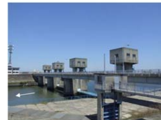
写真 3.1.15 瀬高堰（みやま市） 【矢部川 10k200 付近】
