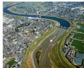
写真 2.2.19 瀬高堰 (みやま市)
