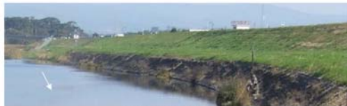
写真 3.3.21 既設護岸状況
