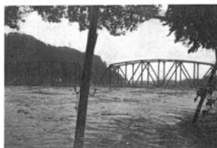
写真 2.2.6 矢部川のはん濫状況（船小屋） （現：筑後市船小屋）
