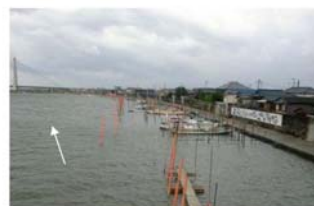
写真 3.1.1 浦島橋右岸側状況（柳川市）
