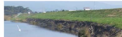
写真 3.3.21 既設護岸状況
