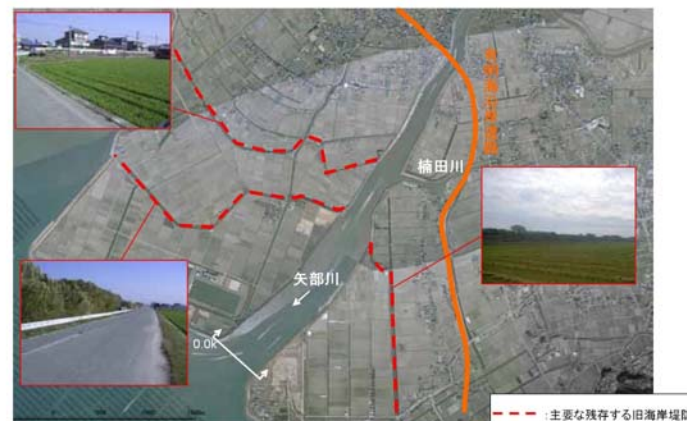
写真 5.3.9 矢部川河口部における旧海岸堤防状況
