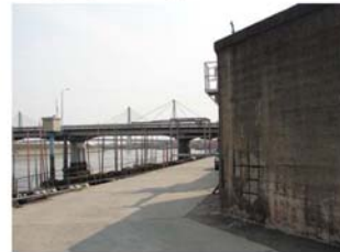
写真 3.1.3 老朽化した特殊堤（川表）① （柳川市住吉中島地区）
