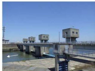
写真 3.1.15 瀬高堰（みやま市） 【矢部川 10k200 付近】
