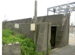
写真 3.1.4 老朽化した特殊堤（川裏）② （柳川市住吉中島地区）
