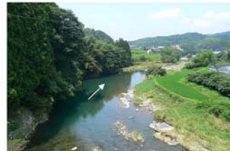
写真 3.3.1 上流部の状況（矢部川 37k 付近） （八女市黒木町）
