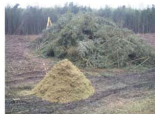
写真 5.3.3 竹チップによるリサイクル (伐竹材を粉砕してチップ化 嘉瀬川での事例)
