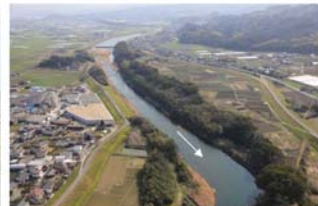
写真 3.1.2 河道内樹木繁茂状況 (筑後市・みやま市)
