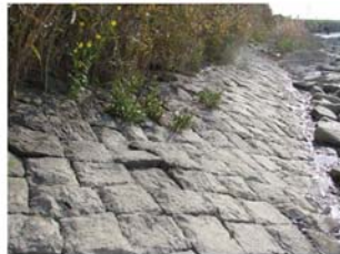
写真 3.1.9 老朽化した堤防護岸
