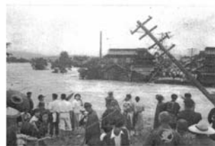
写真 2.2.4 光友村山崎地内 中島橋流出 （現：八女市立花町）
