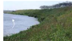
写真 3.3.20 船小屋地区の河川状況 (河川敷が狭く、河川敷及び水際へ安全にアクセスができない)
