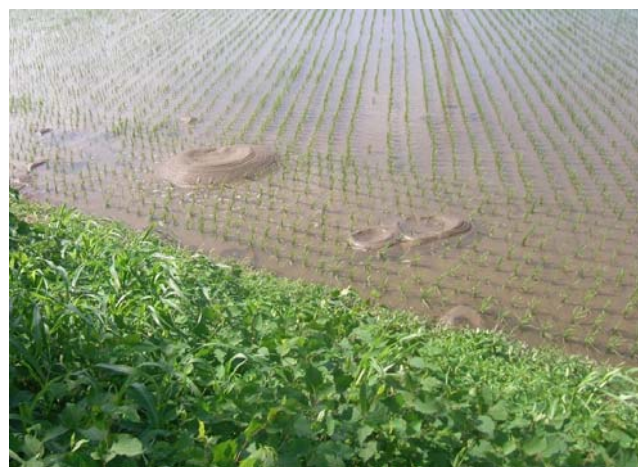
写真 1.2.16 堤防法尻周辺の噴砂状況
