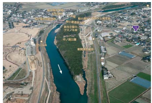
写真 1.1.3 矢部川中流部（船小屋温泉大橋付近）
