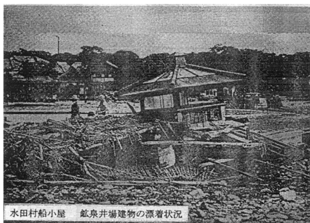
写真 1.2.3 水田村船小屋 鉾泉井場建物の漂着状況 （現：筑後市）
