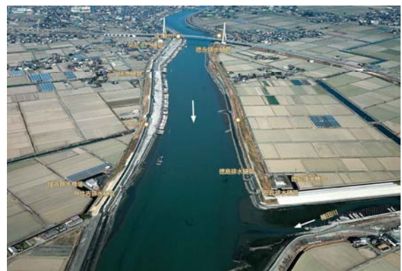
写真 1.1.4 矢部川下流部（楠田川合流点付近）
