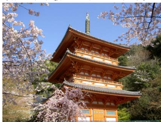
写真 1.1.6 県有形文化財 清水寺三重塔 （みやま市瀬高町）
