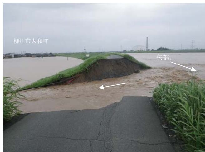
写真 1.2.14 堤防の決壊状況（矢部川右岸 7/300）
