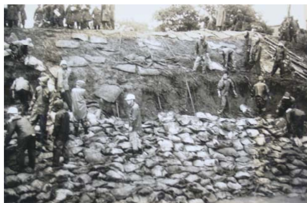
写真 1.2.11 矢部川氾濫後の復旧 (現：みやま市瀬高町)
