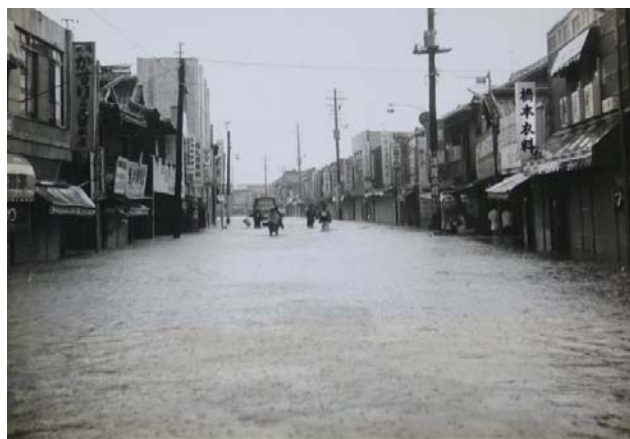
写真 1.2.9 浸水した町中の状況 (現：みやま市瀬高町)
