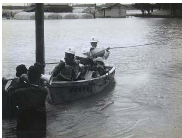
写真 1.2.8 孤立した住民の救出 (現：みやま市瀬高町)
