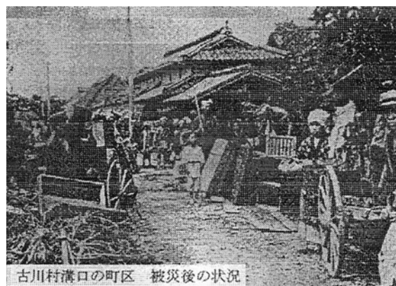
写真 1.2.2 古川村溝口の町区 被災後の状況（現：筑後市）
