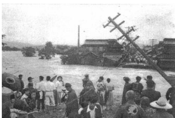
写真 1.2.4 光友村山崎地内 中島橋流出 (現：八女市立花町)
