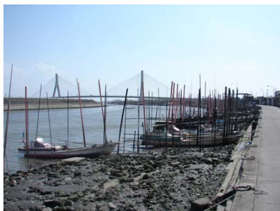
写真 2.1.11 浦島橋下流部右岸側
