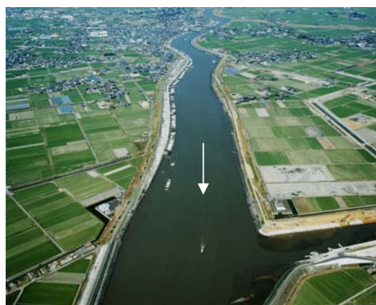
写真 2.1.4 矢部川下流部（楠田川合流点付近）
