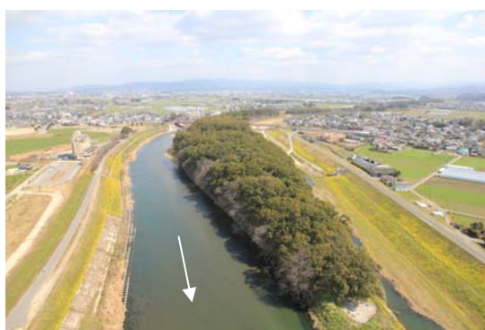
写真 2.1.3 矢部川中流部（船小屋温泉大橋付近）
