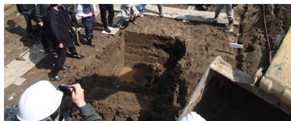
写真 2.1.2 矢部川堤防基礎地盤調査状況
