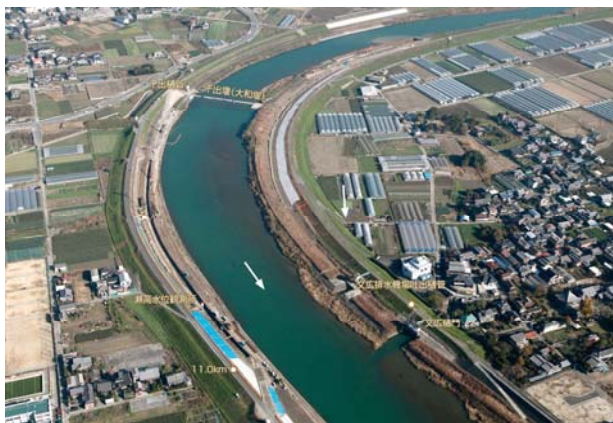
写真 2.3.6 湛水区間の河道状況
