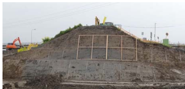
写真 2.1.1 矢部川堤防開削調査状況
