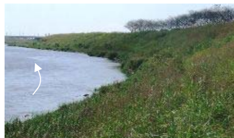
写真 2.3.23 船小屋地区の河川状況 (河川敷が狭く、河川敷及び水際へ 安全にアクセスができない)
