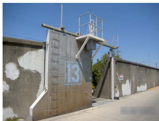
写真 2.1.15 陸閘（柳川市） 【矢部川右岸 4/400 付近】
