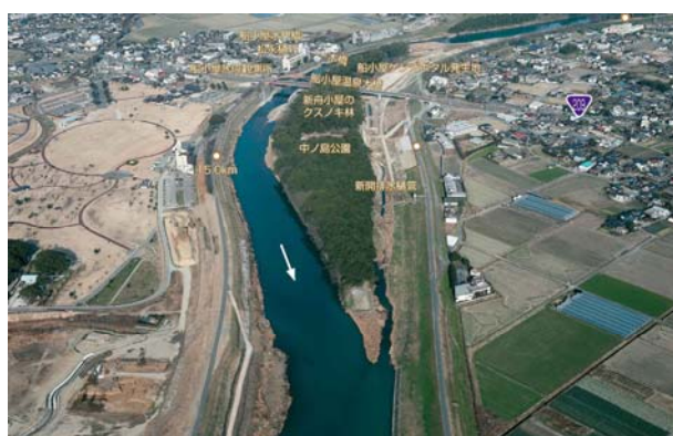
写真 2.3.3 中流部の河道状況
