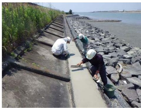
写真 5.2.4 護岸の補修
