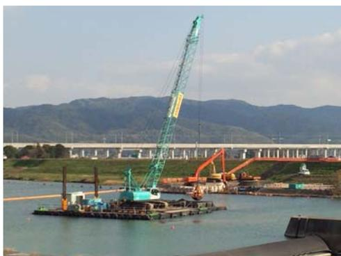
写真 5.2.3 河道内の堆積土砂撤去
