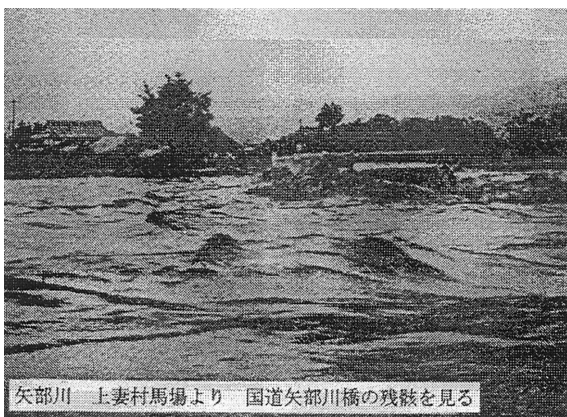
写真 2.2.1 矢部川上妻村馬場より 国道矢部川橋の残骸（現：八女市）
