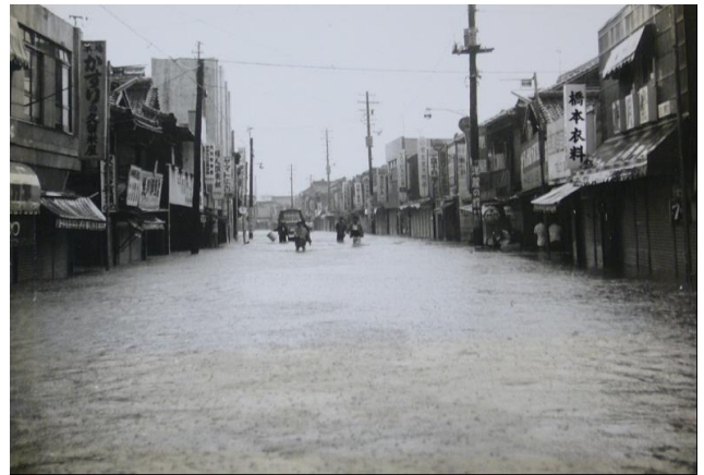
写真 2.2.9 冠水した町中の状況 （現：みやま市瀬高町）
