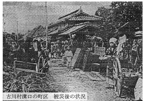
写真 2.2.2 古川村溝口の町区 被災後の状況（現：筑後市）
