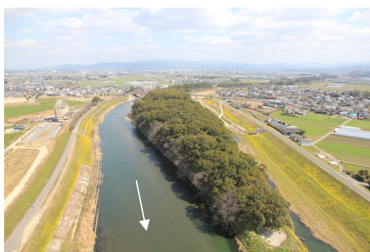
写真 2.1.3 矢部川中流部（船小屋温泉大橋付近）
