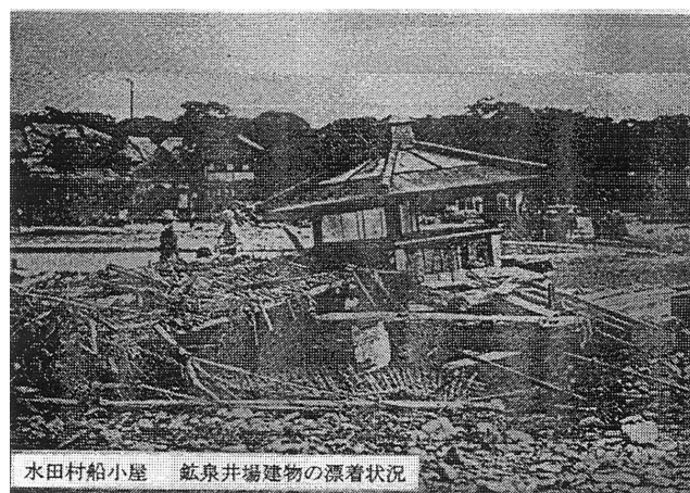
写真 2.2.3 水田村船小屋 鉾泉井場建物の漂着状況 （現：筑後市）
