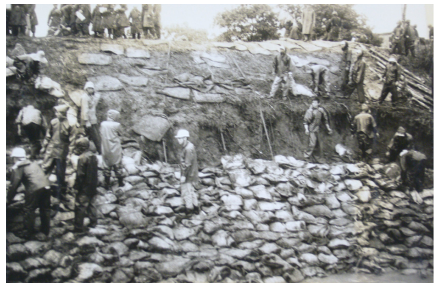
写真 2.2.11 矢部川はん濫後の復旧状況 （現：みやま市瀬高町）
