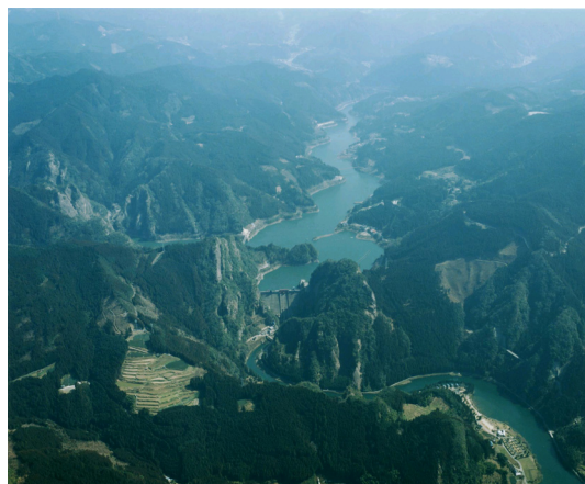
写真 2.1.2 矢部川上流部（日向神ダム付近）
