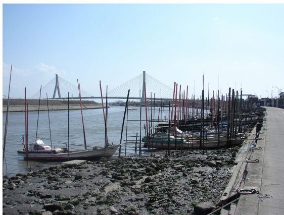
写真 2.1.11 浦島橋下流部右岸側
