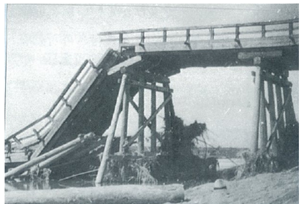
写真 2.2.7 洪水により壊れた幸作橋 （現：みやま市瀬高町）
