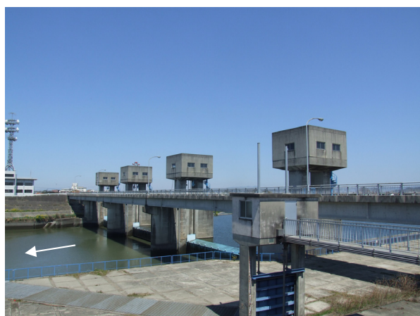
写真 3.1.15 瀬高堰（みやま市） 【矢部川 10k200 付近】
