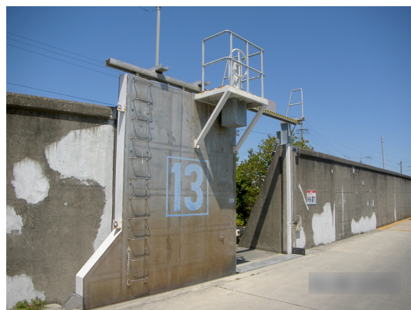
写真 3.1.16 陸閘（柳川市） 【矢部川右岸 4k400 付近】
