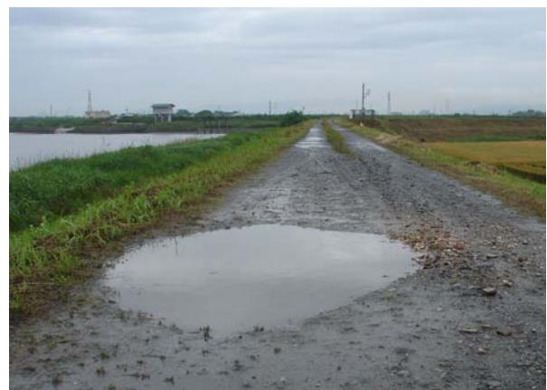
写真 3.1.10 堤防天端の不陸による水溜まり状況
