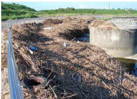
写真 3.3.25 洪水後、松原堰に漂着した塵芥
