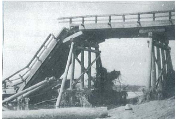
写真 2.2.7 洪水により壊れた幸作橋
