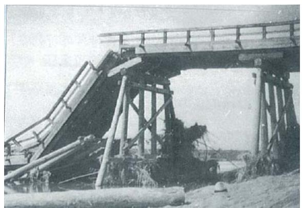
写真 2.2.7 洪水により壊れた幸作橋
