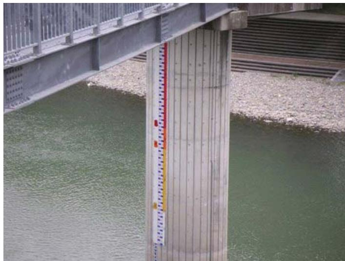
写真 5.3.6 川の水位情報（危険度レベル）を印として現地に設置した例
