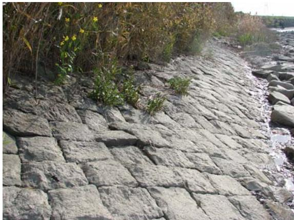
写真 3.1.9 老朽化した堤防護岸
