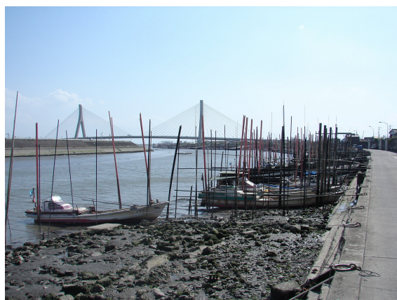
写真 2.1.11 浦島橋下流部右岸側
