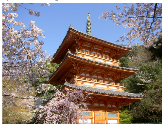
写真 2.1.6 県有形文化財 清水寺三重塔 （みやま市瀬高町）
