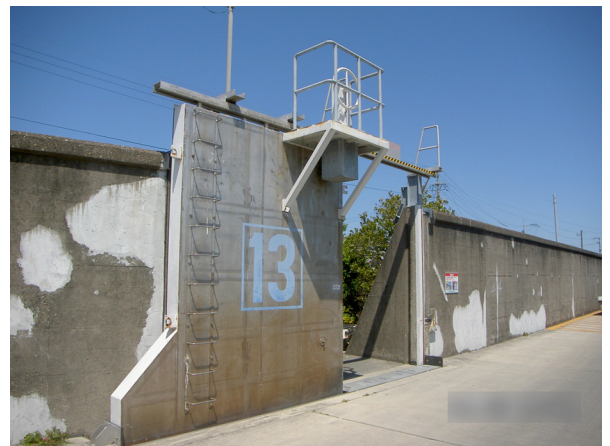
写真 3.1.16 陸閘 (柳川市) 【矢部川右岸 4k400 付近】
