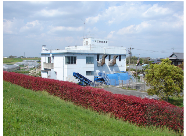
写真 3.1.14 文広排水機場 (みやま市) 【矢部川左岸 11k000 付近】
