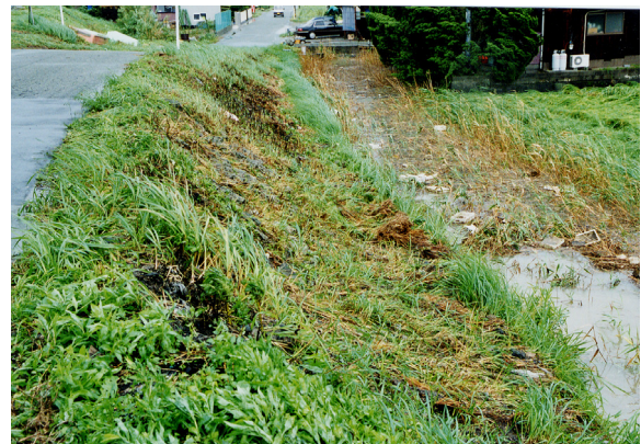
写真 3.1.6 平成 11 年楠田川高潮越波状況 （みやま市高田町江浦地区）
