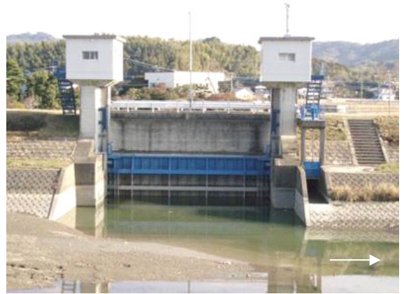
写真 3.1.12 古賀水門 (みやま市) 【飯江川左岸 3k000 付近】
