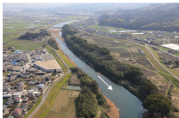
写真 3.1.2 河道内樹木繁茂状況 （筑後市・みやま市）
