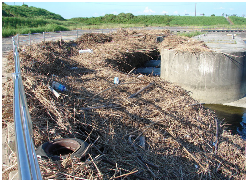
写真 3.3.25 洪水後、松原堰に漂着した塵芥
