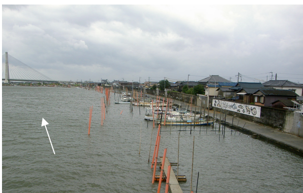
写真 3.1.1 浦島橋右岸側状況（柳川市）
