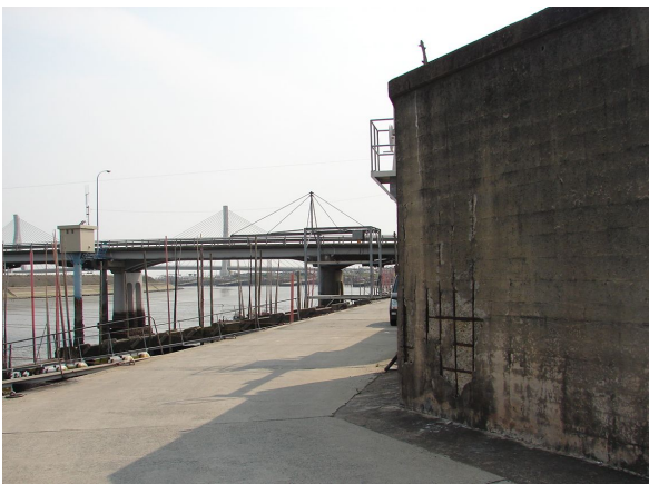
写真 3.1.3 老朽化した特殊堤（川表）① （柳川市中島地区）
