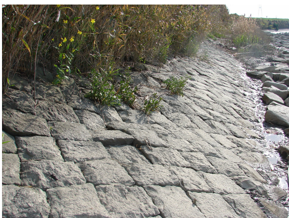
写真 3.1.9 老朽化した堤防護岸
