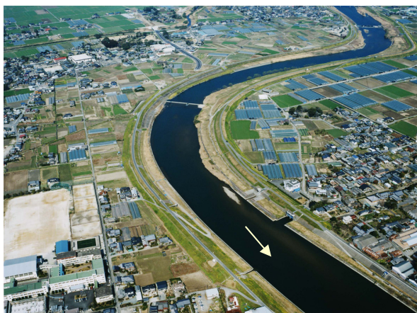
写真 3.3.7 湛水区間の河道状況
