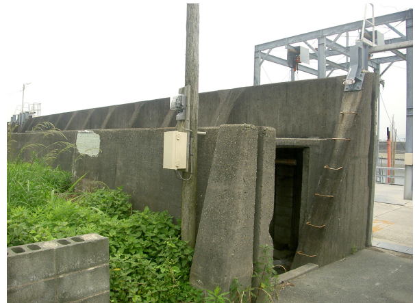
写真 3.1.4 老朽化した特殊堤（川裏）② （柳川市中島地区）
