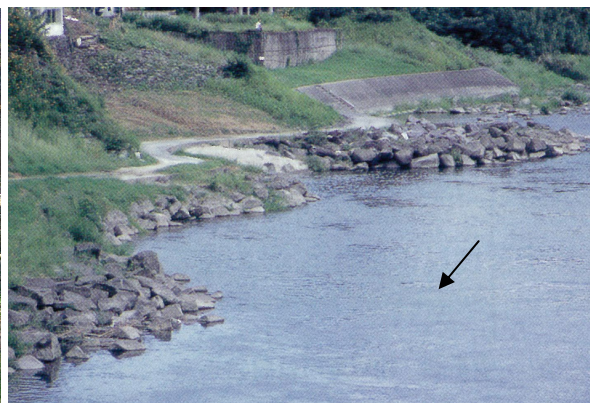
写真 5.2.2 筑後川における水刳 (朝倉市 筑後川右岸 59k600 付近)
