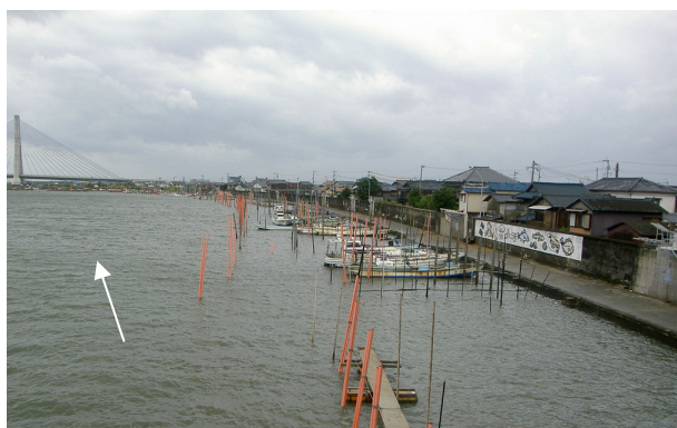
写真 3.1.1 浦島橋右岸側状況（柳川市）
