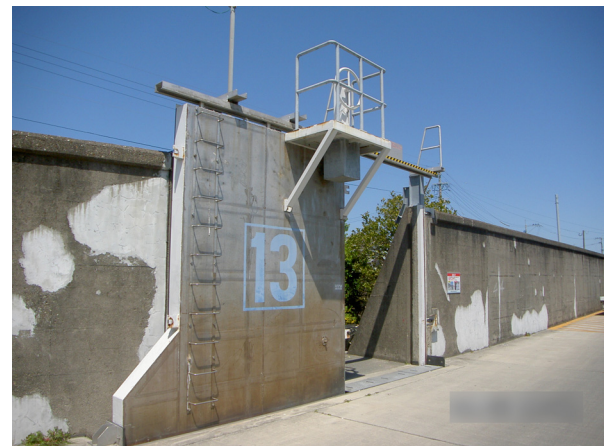
写真 3.1.16 陸閘（柳川市） 【矢部川右岸 4k400 付近】
