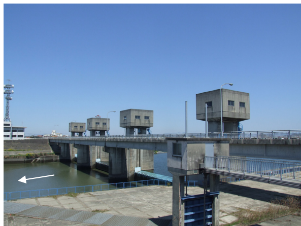
写真 3.1.15 瀬高堰（みやま市） 【矢部川 10k200 付近】
