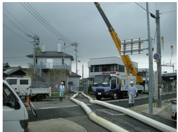
写真 3.1.8 排水ポンプ車による排水作業（柳川市）
