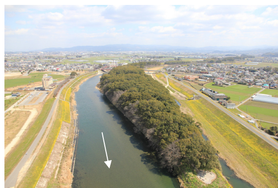
写真 2.1.3 矢部川中流部（船小屋温泉大橋付近）
