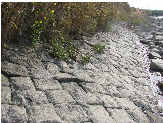
写真 3.1.9 老朽化した堤防護岸
