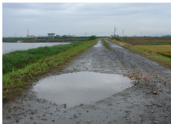
写真 3.1.10 堤防天端の不陸による水溜まり状況
