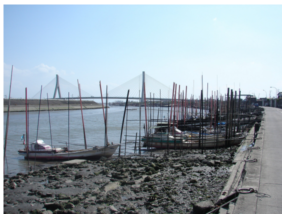
写真 2.1.11 浦島橋下流部右岸側
