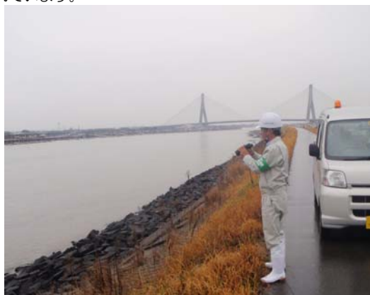
写真 5.3.1 河川巡視状況
