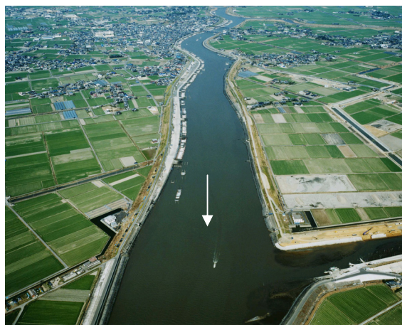
写真 2.1.4 矢部川下流部（楠田川合流点付近）
