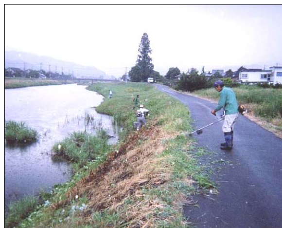
地域住民による堤防の除草(朝倉市)
