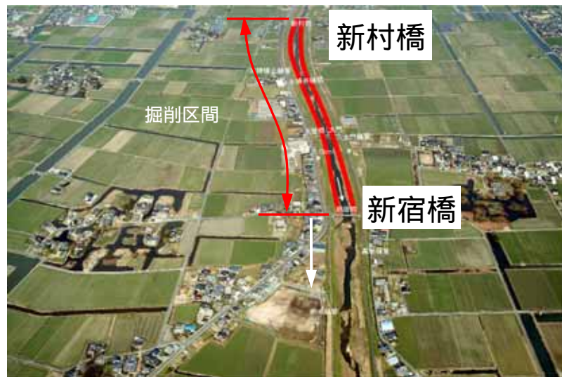
平成18年度の河道掘削工事予定の区間
