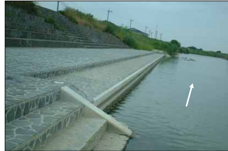
護岸完成状況
