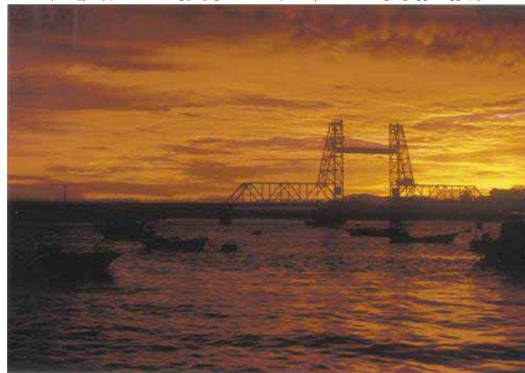
昇開橋(大川市・佐賀市)
