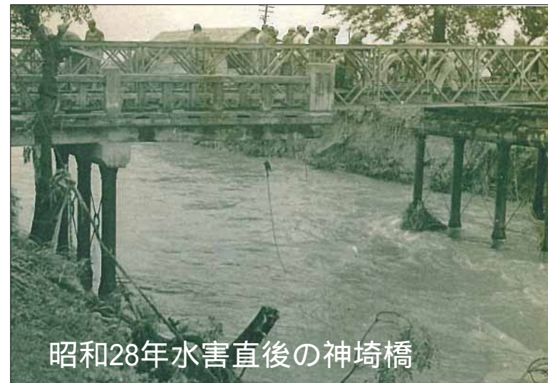
昭和28年水害直後の神埼橋
