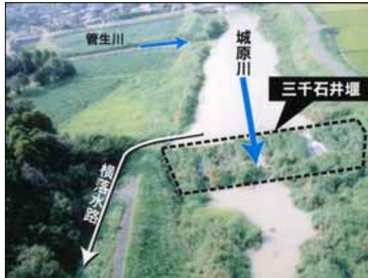
三千石井落水路
