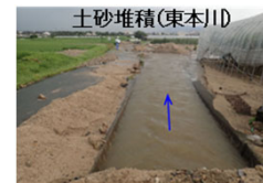
土砂堆積(東本川)
