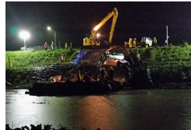
応急対策状況
