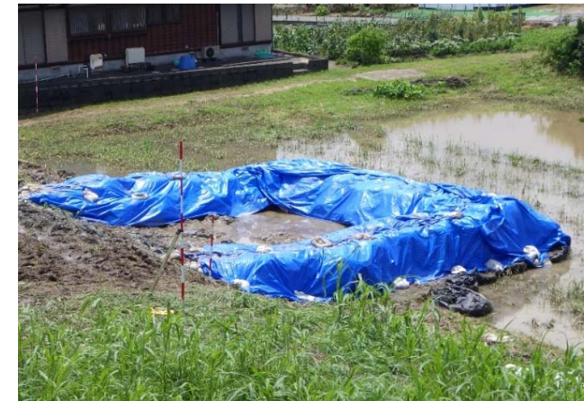
応急対策状況
