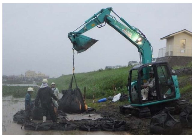
応急対策状況
