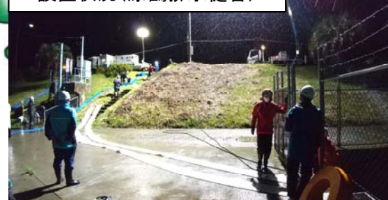
設置状況(原鶴排水樋管)
