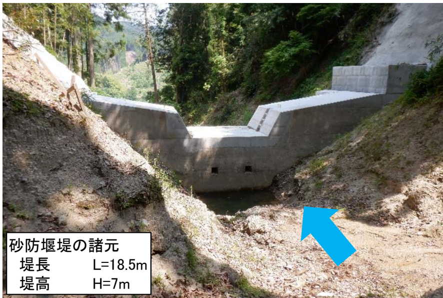
土砂捕捉前 (R2. 5. 28撮影)
