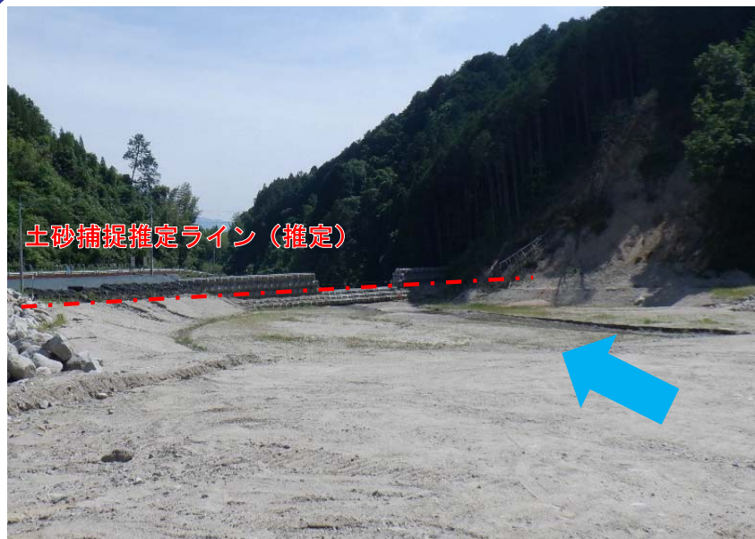
土砂捕捉前（R2. 6. 2撮影）
