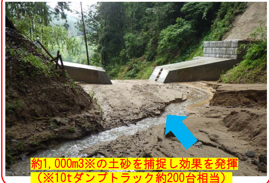
土砂捕捉後 (R2. 7. 8撮影)
