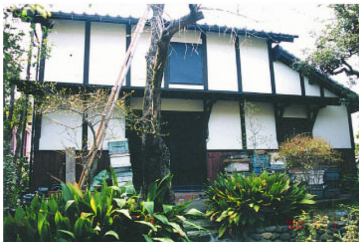
鳥栖市高田町に残る水屋
