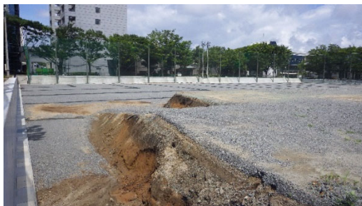
写真-3 久留米大学貯留施設の整備の様子
