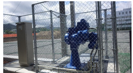
写真-4 貯留施設の排水ゲート
