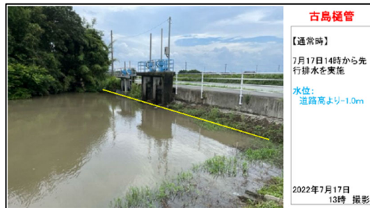
写真-2 クリーク先行排水前
