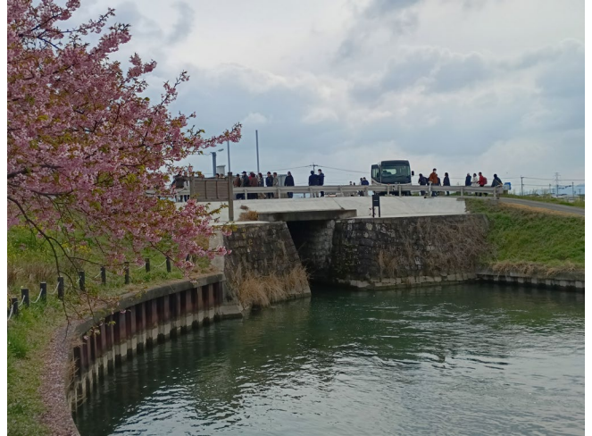
写真2 ニツ川堰左岸側にある石組水門
