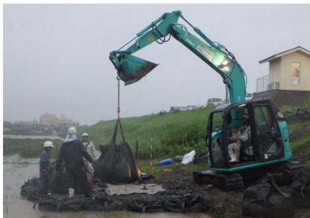
応急対策状況
