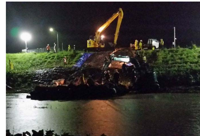
応急対策状況
