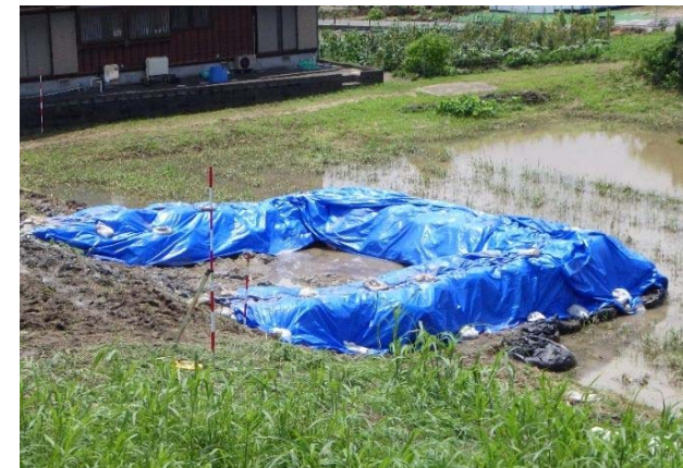
応急対策状況
