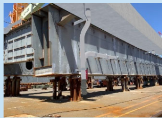
【ARを用いた出来形管理】
