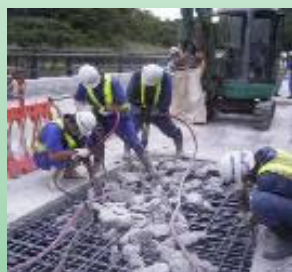
▲修繕・耐震補強
