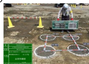
掘り起こしによる杭径・間隔 の確認・埋戻し (杭100本につき1箇所)
