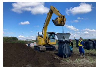
大型土のう工
