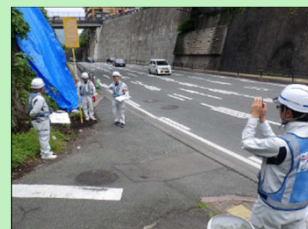
【立会状況（現場側）】
