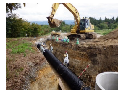
排水構造物工（暗渠排水管）
