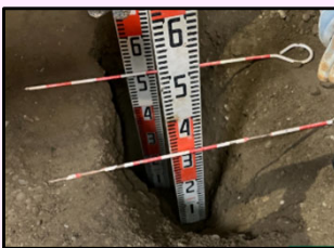
【立会状況（路盤出来形確認）】
