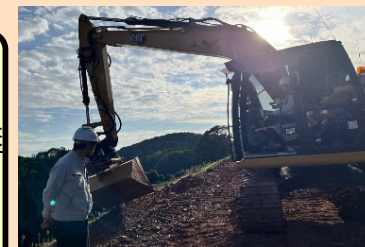
■ICT土木工事現場見学会
