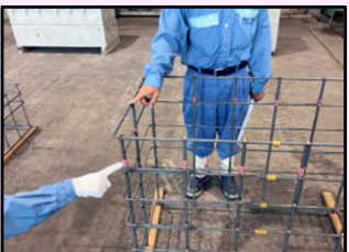
【立会状況（配筋確認）】
