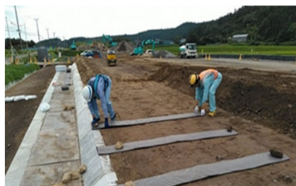
排水材設置工（水平排水層）
