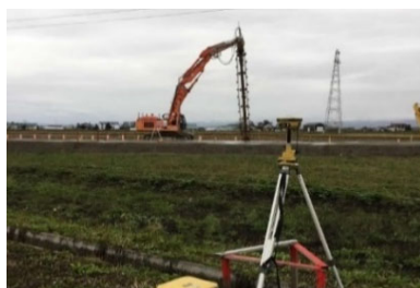
中層混合処理工（ICT）
