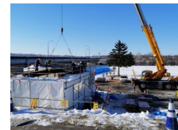
雪寒仮囲い工
