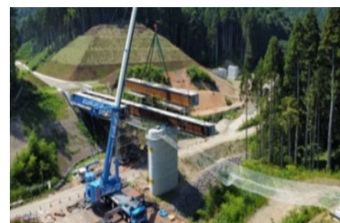
鋼橋架設工
