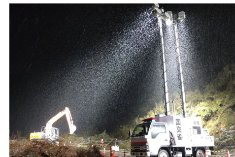
昼夜を徹した道路啓開作業 (石川県)
