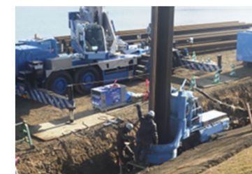
油圧圧入引抜工
