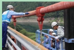
▲国道メンテナンス
