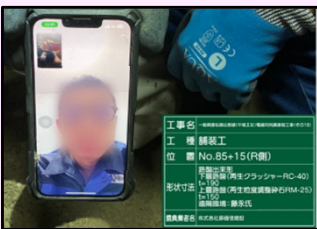
【立会状況（路盤出来形確認）】
