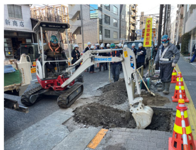
GX建機の実現場での活用事例
