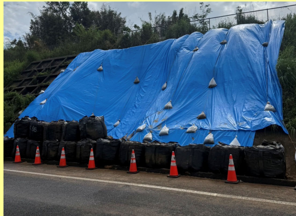
応急復旧状況
