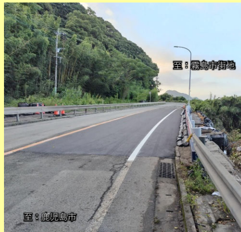
応急復旧状況
