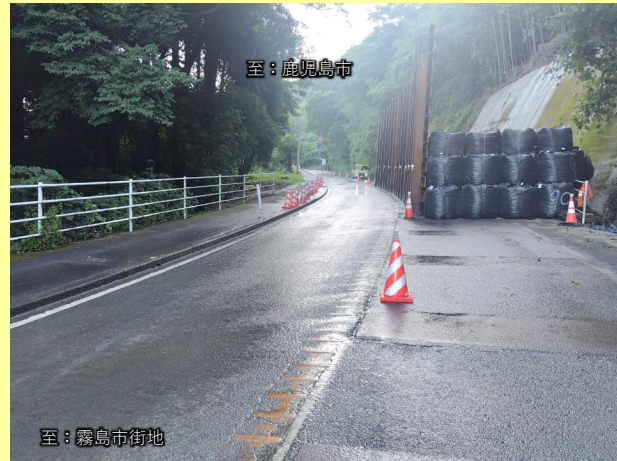
応急復旧状況
