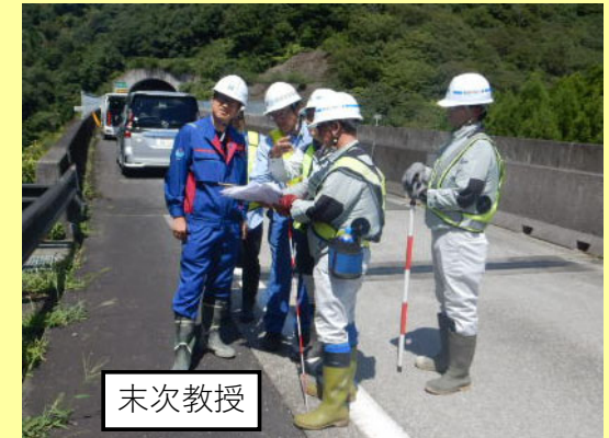
現地打合せ状況
