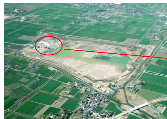
巨勢川調整池
