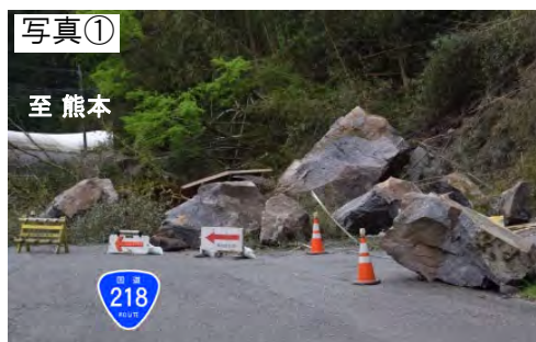
▲H28熊本地震 国道218号
