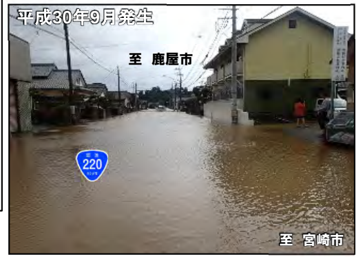
【写真①】大雨時の冠水(串間市)
