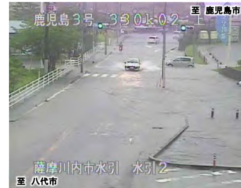
▲ 大雨による冠水状況 (R2.5)
