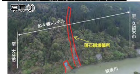
▲H28熊本地震による被災状況
