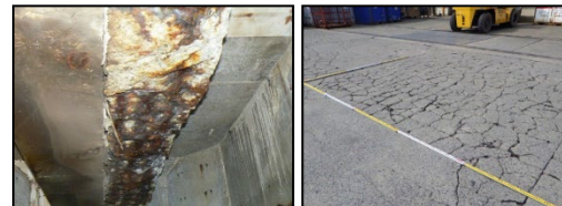
本港地区岸壁(水深7.5m)
