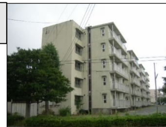
老朽化した市営住宅
