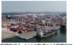
▲国際物流ターミナルの整備による国際船舶・貨物輸出入を強化する取組 【博多港 アイランドシティコンテナターミナル】
