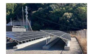
太陽光発電施設の設置
