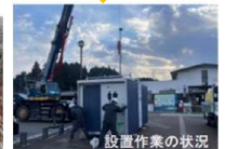
設置作業の状況
