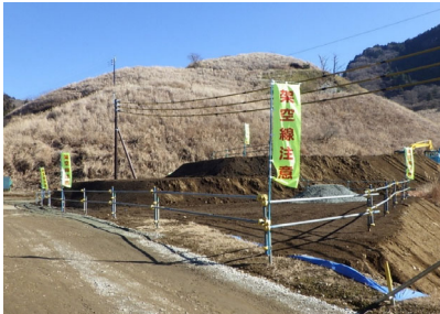
防護カバーの設置 「架空線注意」のぼり旗設置
