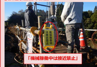
② 接近禁止柵の設置
