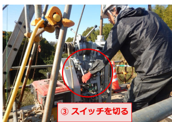
【「逆打ち作業」実施時の対策】
