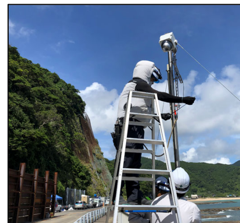
宮浦地区【カメラ据付作業】
