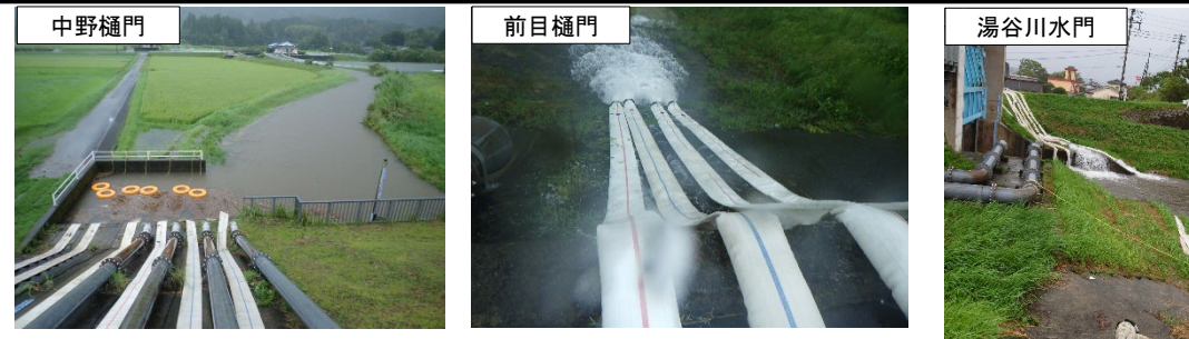
排水ポンプ車による排水状況
