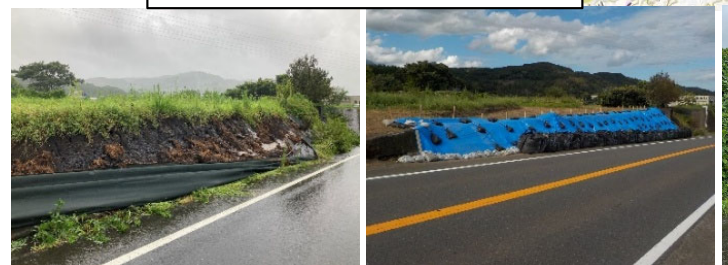
112k540 下り 被災状況・応急復旧状況
