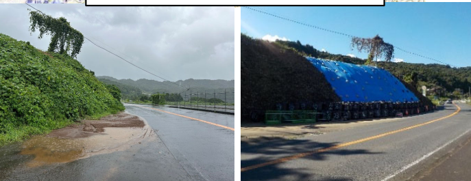
115k360 下り 被災状況・応急復旧状況
