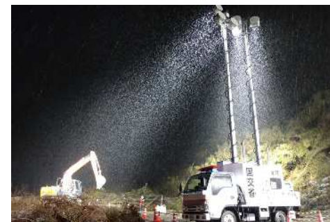
昼夜を徹した道路啓開作業 (石川県)
