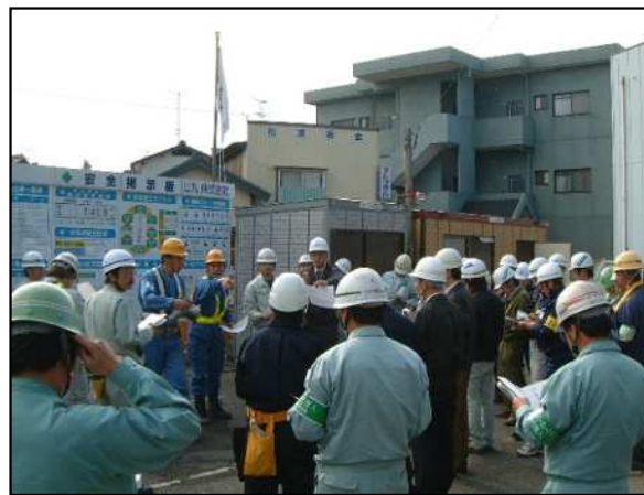
安全パトロールの実施
