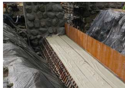
仮締切工（砂防コンクリート締切）
