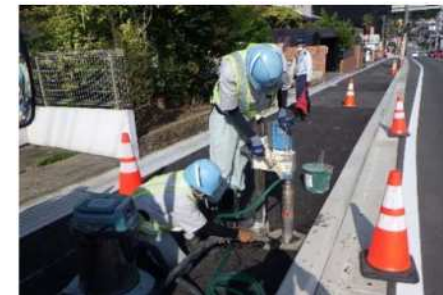
舗装版削孔工
