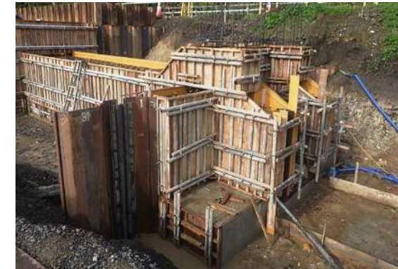
型枠工（省力化構造）
