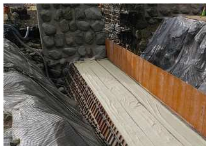
仮締切工（砂防コンクリート締切）
