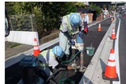
舗装版削孔工
