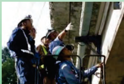
▲ 橋梁に対する診断
