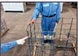
【立会状況（配筋確認）】
