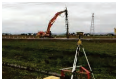
中層混合処理工（ICT）
