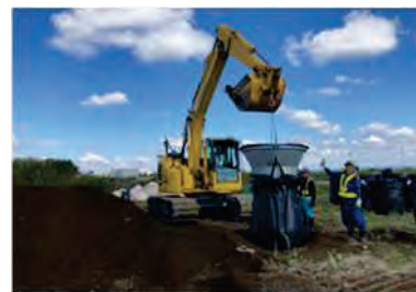
大型土のう工
