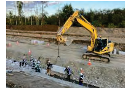
護岸基礎ブロック据付工
