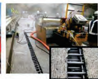
<ウォータージェットはつり処理工法>
