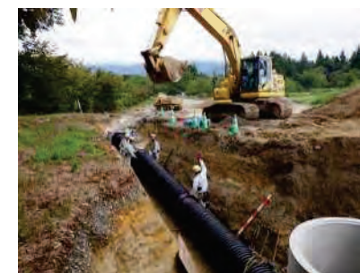
排水構造物工（暗渠排水管）
