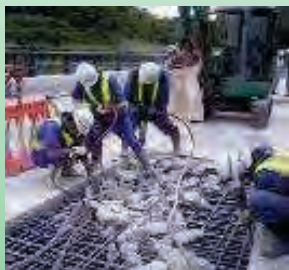
▲ 修繕・耐震補強
