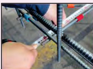
【立会状況（配筋確認：近接）】
