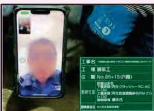
【立会状況（路盤出来形確認）】
