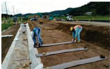
排水材設置工（水平排水層）
