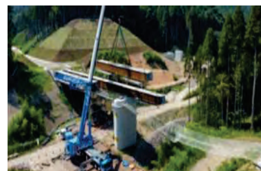
鋼橋架設工
