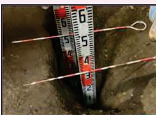
【立会状況（路盤出来形確認）】
