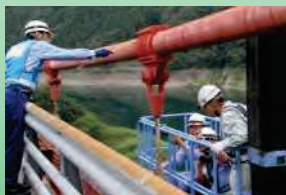
▲ 国道メンテナンス
