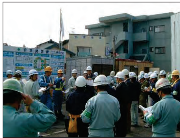
安全パトロールの実施
