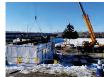
雪寒仮囲い工
