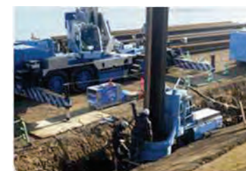
油圧圧入引抜工
