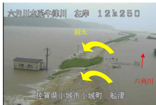
写真-2 堤防からの越水状況
